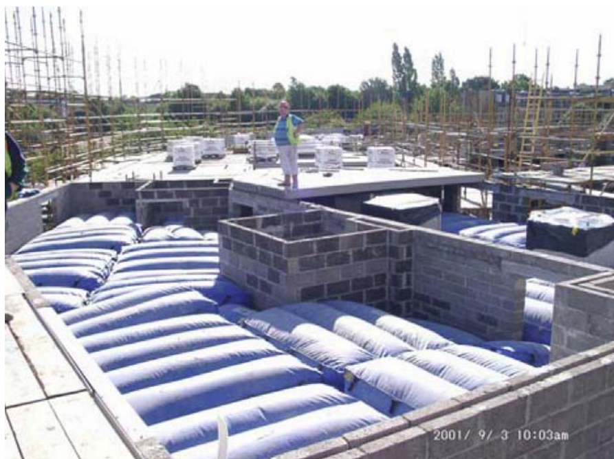
Figura 34. Impiego di materassi di protezione ( air-mat ).
