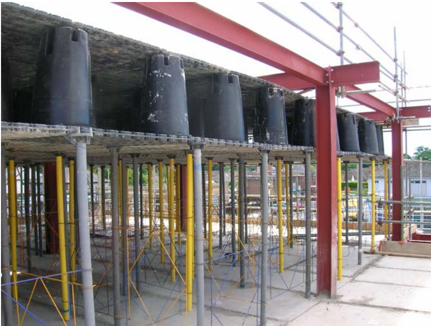
Figura 41. Puntelli di sostegno.
