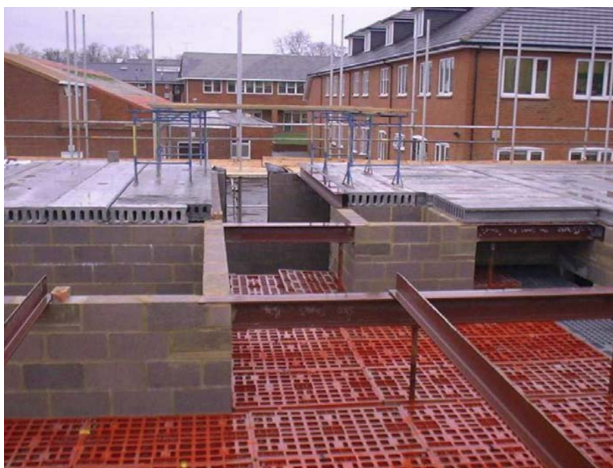
Figura 38. Impalcato di protezione.
