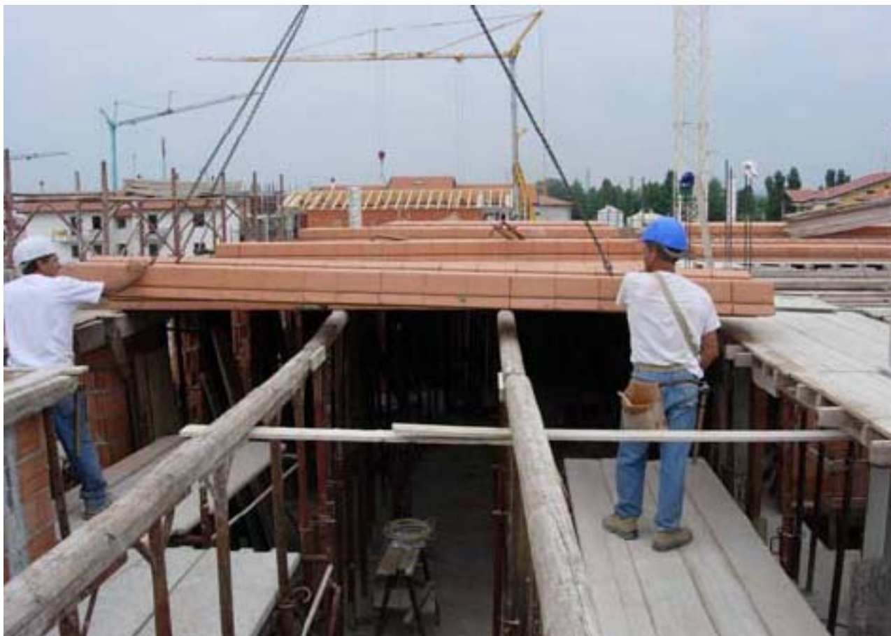
Figura 15. Posa di pannelli utilizzando ponti su cavalletti 42 .
