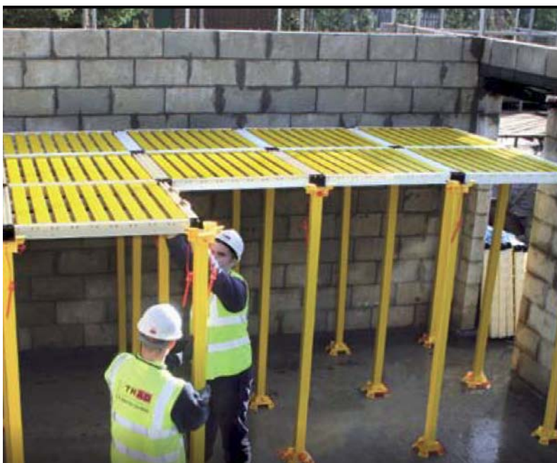
Figura 37. Operazioni di montaggio (TRAD Safety Deck)
