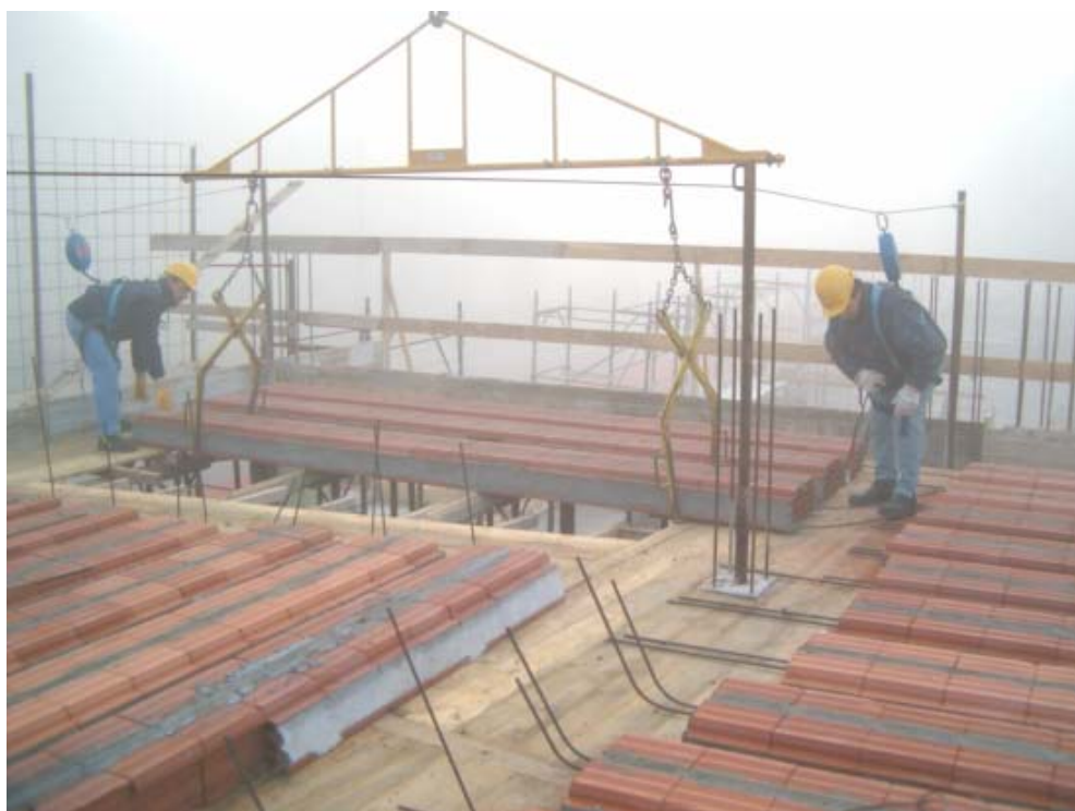
Figura 23. Posa con DPI anticaduta 56 .
