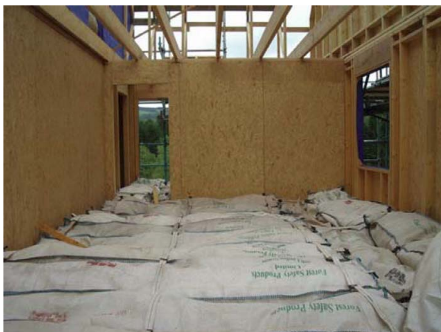
Figura 35. Impiego di materassi di protezione ( soft-filled-mat ).
